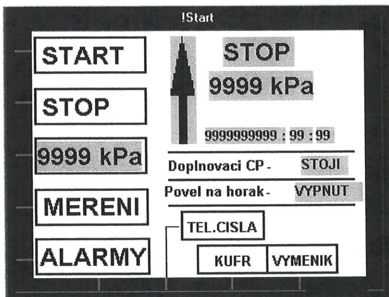
OBRÁZEK 1.0 Čelní pohled na panel řídicího systému tak jak je nainstalován na rozvaděči. Na displeji je úvodní stránka parametrů a informací parního kotle.
